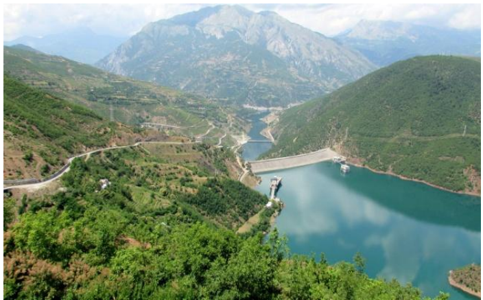
Foto 10.2.2: Hidrocentrali i Komanit
